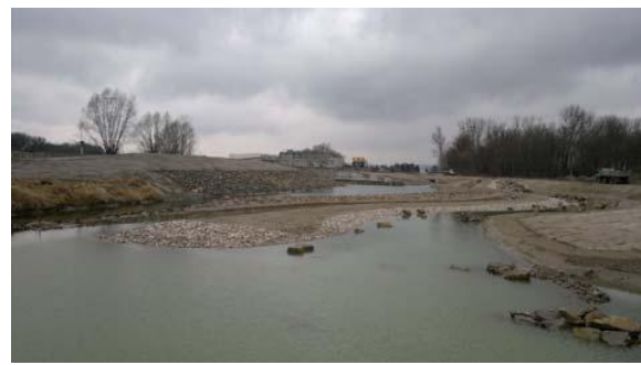
Die Flutmulde an der Mündung in die Donau
